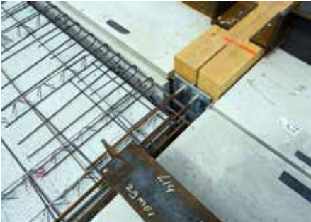
6. Speciale koppelplaat met aangelaaste ankers.
