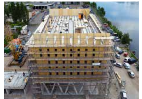
11. De kopegevels van kruislaag gelamineerd hout.
