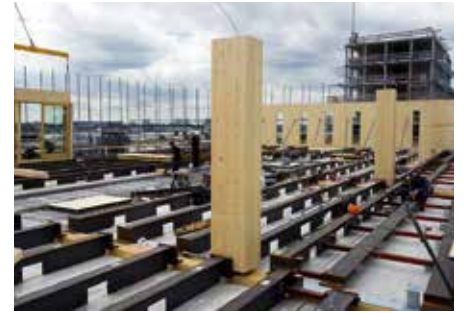
8. De vloeren werken als stabiliteitschijf.
