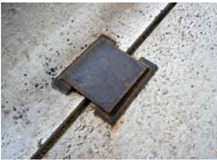
9. Een kikkerplaat koppelt de vloerplaten onderling.
