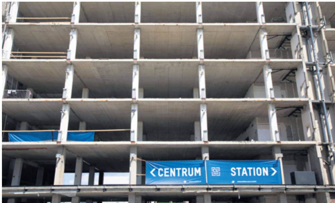
Sloop van verouderde kantoorgebouwen uit de jaren 70 op het Jaarbeursplein in Utrecht.
